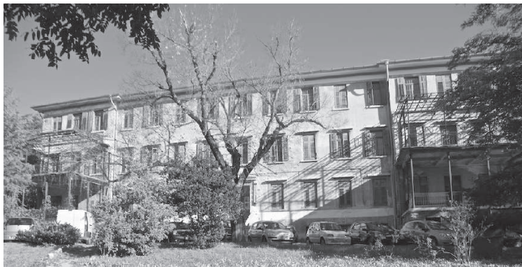
Figura 7.6 - L'immobile di Piazzale Canestrini.
